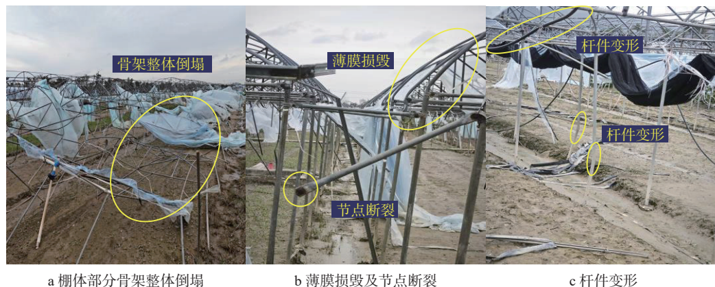
图 9 调研地点 6 处薄膜温室结构破坏形式
