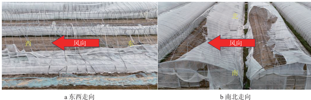
图8 农业温室结构倒塌方向与风向示意图
